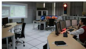
现场总线技术及自动化重点实验室
